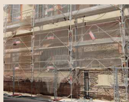
Chantier de réfection d'un mur de briques rue Antoine Deville
