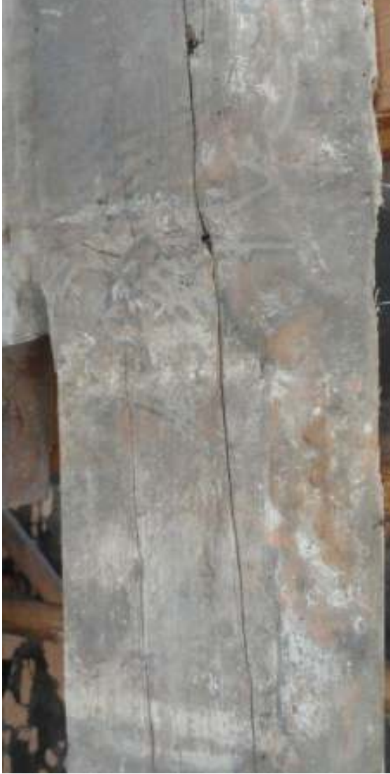
Encroûtement de poussière sur la planche des chevaliers.
