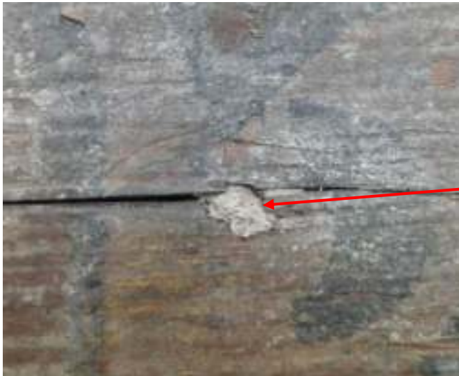
Bouchage d'un trou de clou avec de l'enduit à la chaux.
