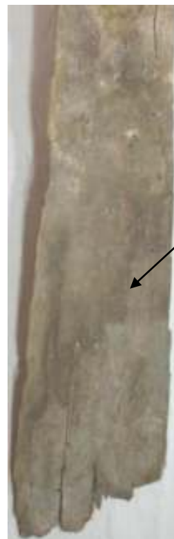
Traces de coulures d'eau datant probablement de l'exposition des planches à l'air libre après leur démontage.
