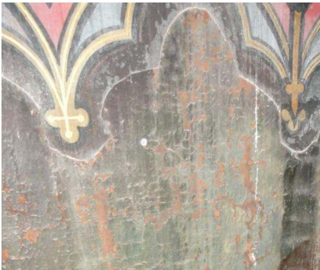
On remarque ici la découpe de la toile encore fixée sur le mur. Les lacunes de toile sont en grande partie concentrées dans la partie centrale supérieure où le ruissellement a été le plus important. Les soulèvements sont généralisés dans cette zone.
