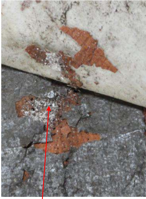
Les sels ont cristallisés sous la couche picturale entraînant les soulèvements que l'on peut voir ci-dessus (ils apparaissent ici sous forme de taches blanches).
