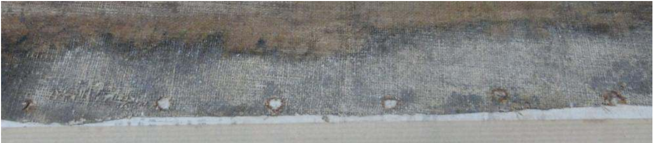
Dégagement des mastics à l'huile qui étaient passés au travers de la toile avant puis après intervention.
