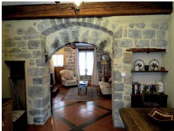
Fig. 14 : arrière-voussure d'une arcade du mur de refend, vue depuis le nord (J. Foltran).
